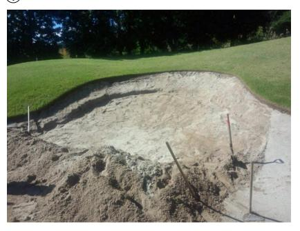
**バンカーローンを設置する個所の砂を退かす。** 芝面との境目をきれいにすると仕上がりが良くなります。 また、最深部に施工することにより、砂の流亡をより効果 的に防ぐことが出来ます。
